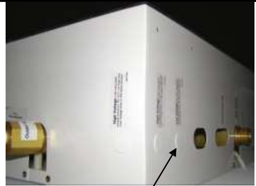
Orificio para cableado de alarma remota de baja tensión
