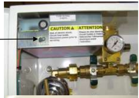
Orificio de conducto para señales de alarma de baja tensión
